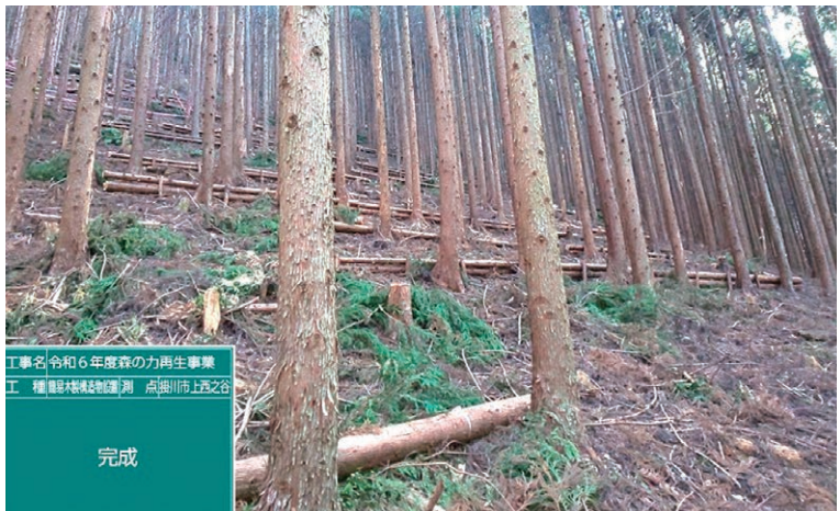
令和6年度に森林整備した現場
